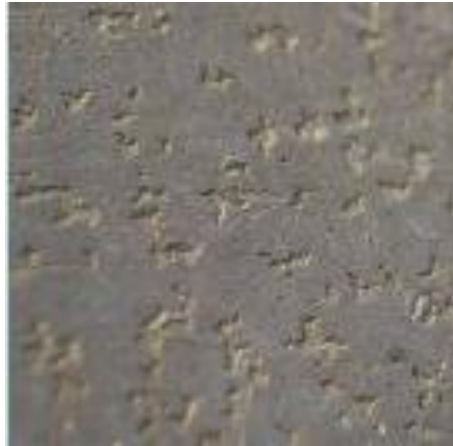
Figura 7.2. Picaduras a causa de fatiga superficial.
